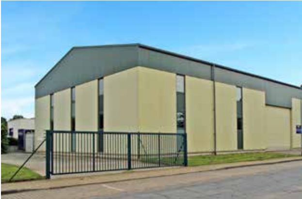
Gebäudeansicht der Battery Care Station
