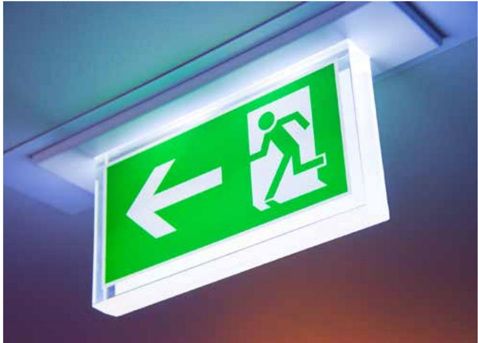
So ist sichergestellt, dass bei Stromausfall und Brandgefahr der Fluchtweg über Rettungszeichenleuchten gezeigt wird und mit einer Mindestlichtstärke beleuchtet ist.
