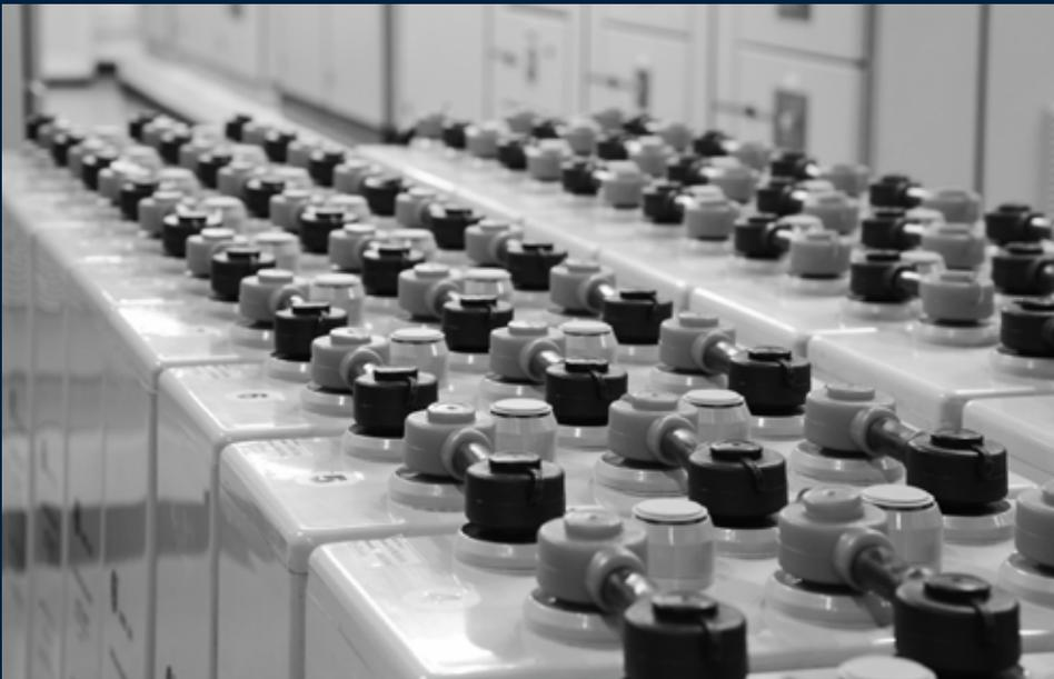
Im Leistungsumfang der Wartung von **stationären Batterieanlagen** ist eine Kapazitätsprobe nach Entladestromtabelle des Herstellers enthalten, womit Sie neben den Routinewartungsarbeiten eine verbindliche Angabe der Leistungsfähigkeit Ihrer Batterie erhalten. Bei kritischen Anwendungen können wir für die Zeit der Kapazitätsprobe eine mitgebrachte Ersatzbatterie zum Verbraucher schalten.
